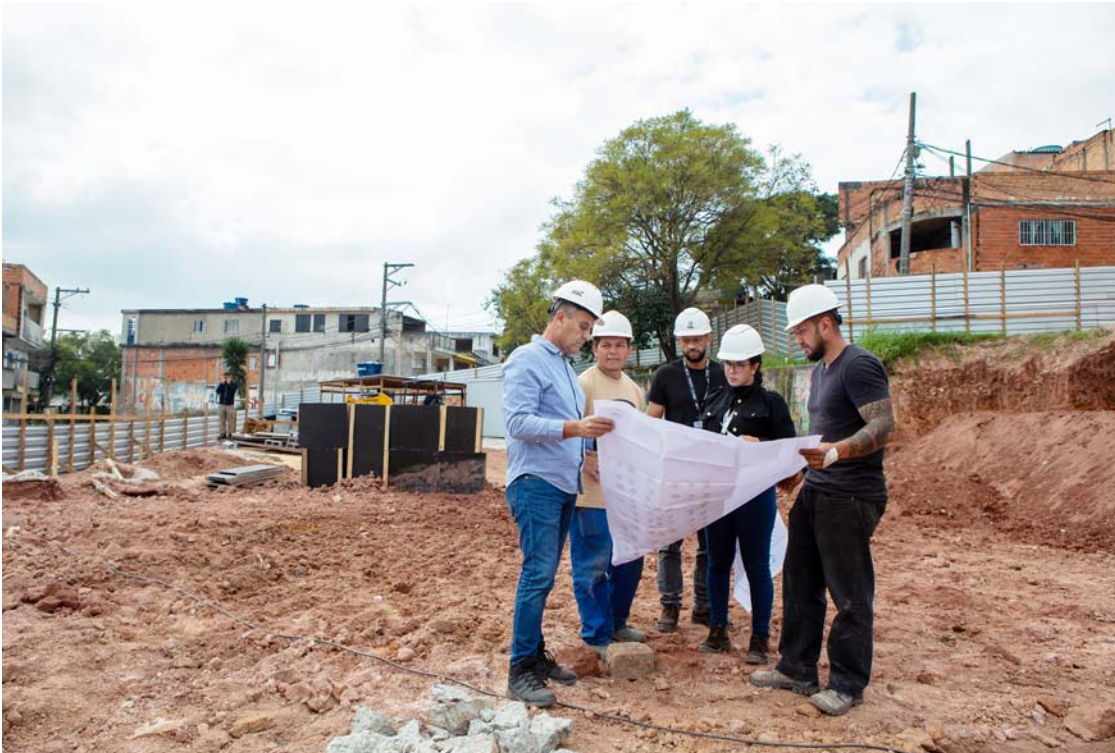
Obras da Unidade Básica de Saúde Cerro Largo tem previsão para atender aproximadamente 13 mil pessoas
