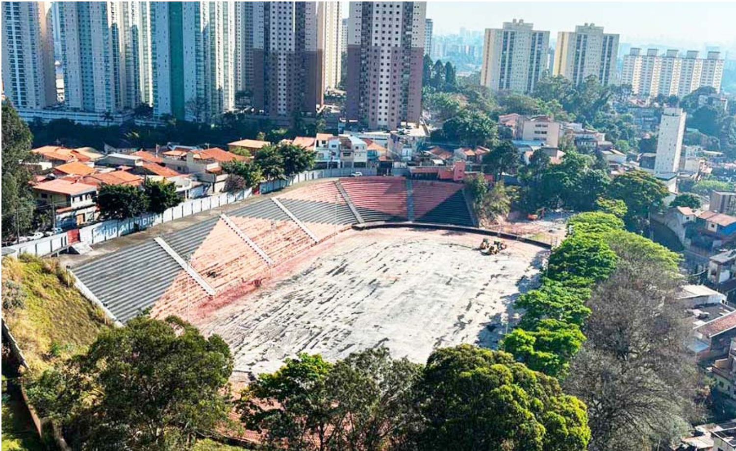
Estádio Municipal de Taboão da Serra, José Feres, passa por uma ampla reforma
