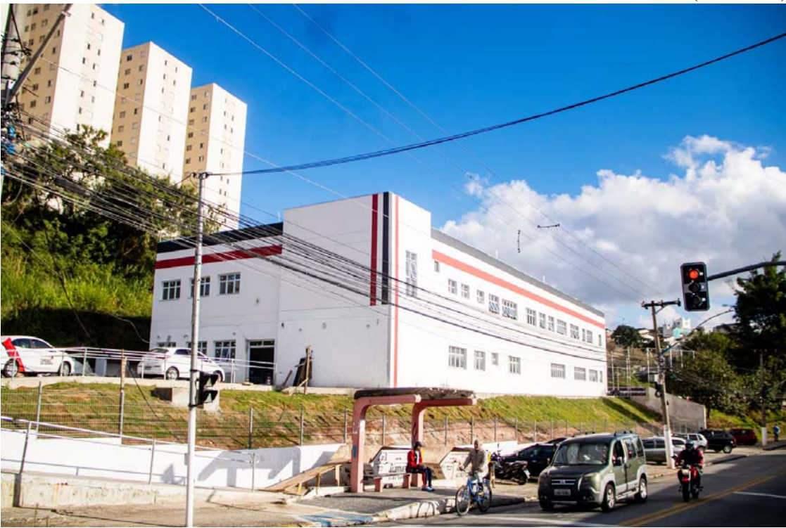
Obras dos novos equipamentos de saúde CAPS I (Centro de Atenção Psicossocial Infantil) e o CEO (Centro de Especialidades Odontológicas) estão em fase final
